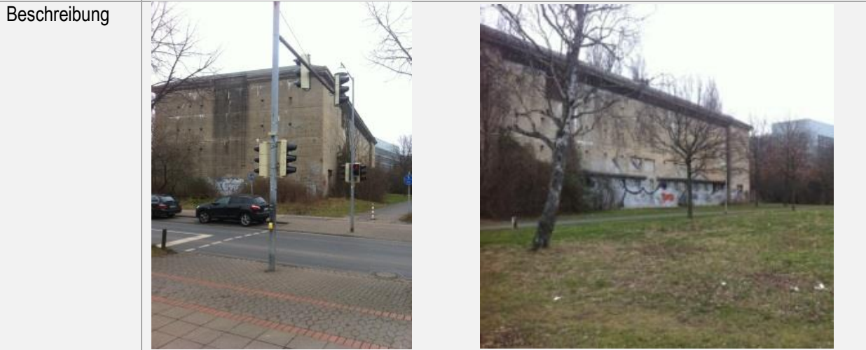
Abbildung 28: Hochbunker Am Listholze
